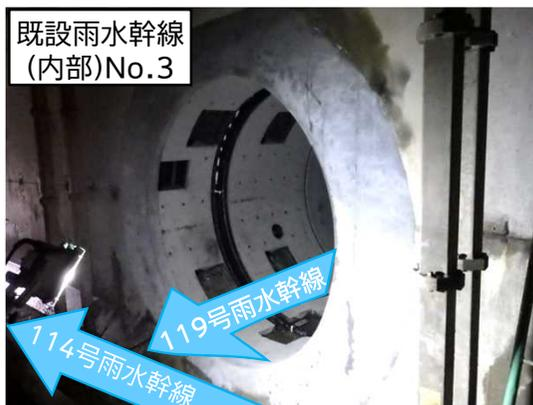
既設雨水幹線との接合処理状況
