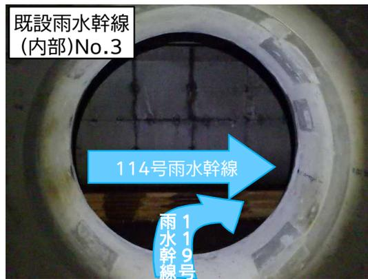
既設雨水幹線との接合処理状況
