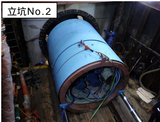
掘進機据付状況
