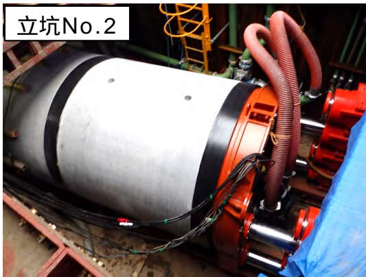
推進工法(U-M管布設)状況
