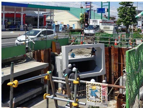
ボックスカルバート布設状況
