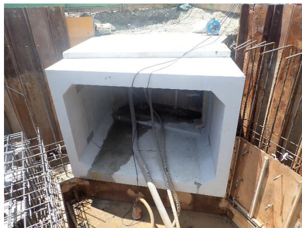
ボックスカルバート布設状況
