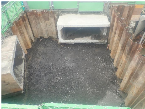
分水人孔築造(基礎工(砕石))状況
