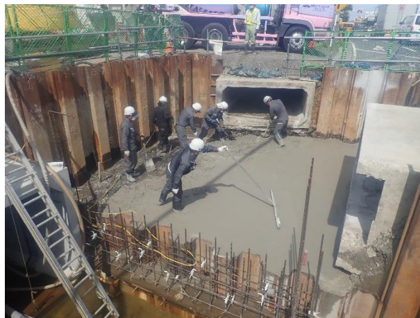
分水人孔築造(基礎工(コンクリート打設))状況
