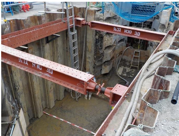
掘削・支保工完了状況
