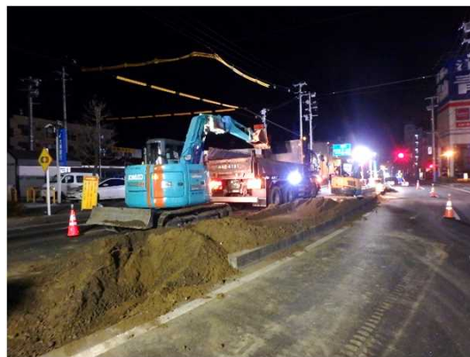
仮設道路工(県道中央分離帯撤去)状況
