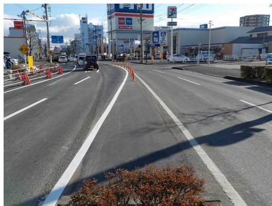
仮設道路工(県道中央分離帯撤去完了)状況
