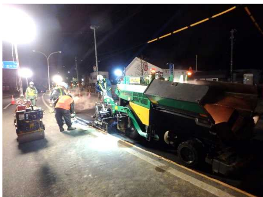
仮設道路工(舗装仮復旧)状況
