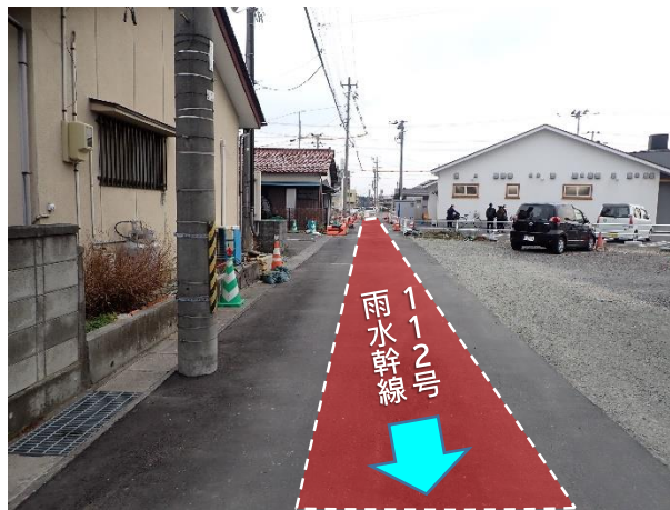
舗装仮復旧完了状況(下流から上流を望む)
