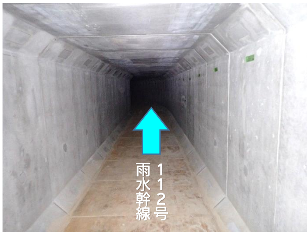
ボックスカルバート布設完了状況(内部)
