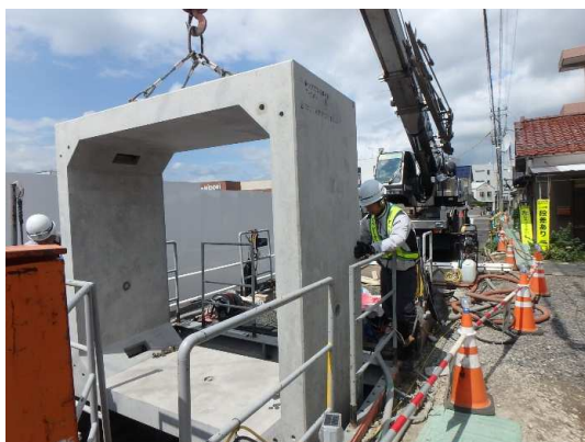
ボックスカルバート布設状況
