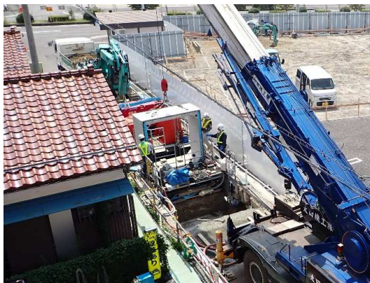
ボックスカルバート布設状況
