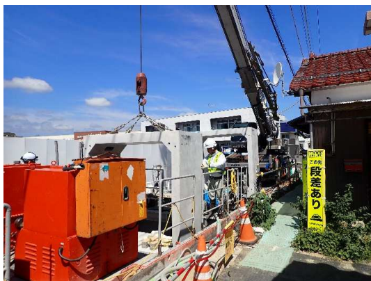
ボックスカルバート布設状況
