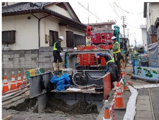
ボックスカルバート布設状況
