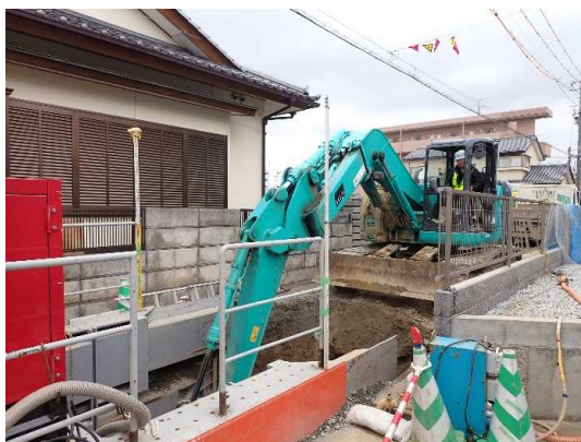
オープンシールド機による掘進(土留・掘削)状況
