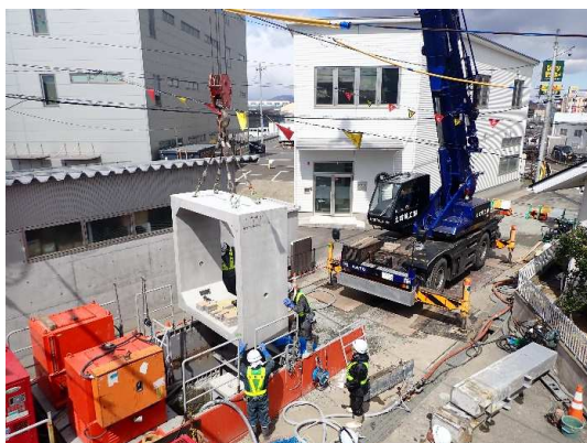
ボックスカルバート布設状況
