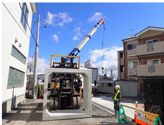
ボックスカルバート布設状況
