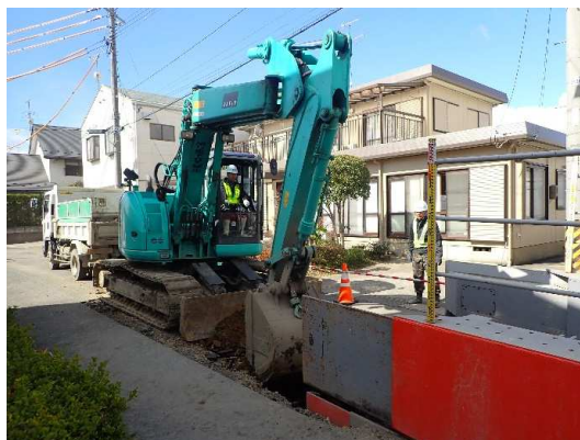
オープンシールド機による掘進(土留・掘削)状況
