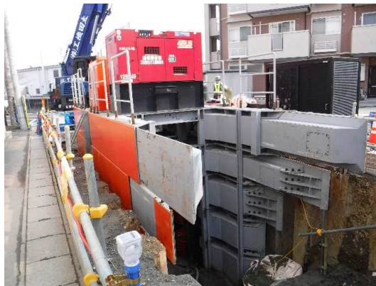
オーブソールト機 ® 組立状況(下流側を望む)
