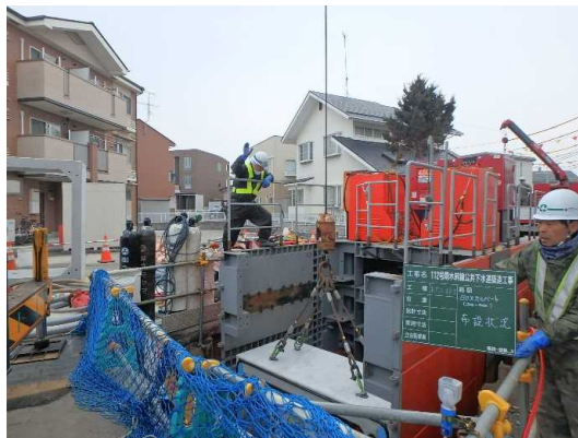
ボックスカーポート ® 布設状況
