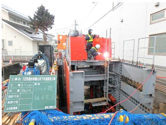
オーブソールト機 ® 組立状況(上流側を望む)
