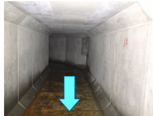
ボックスカルバート内部状況(上流側)
