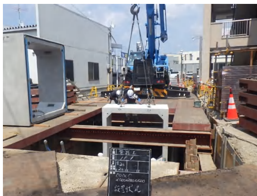
ボックスカルバート布設状況
