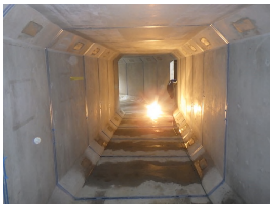
ボックスカルバート布設完了(内部)状況
