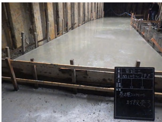
基礎工(コンクリート打設)状況
