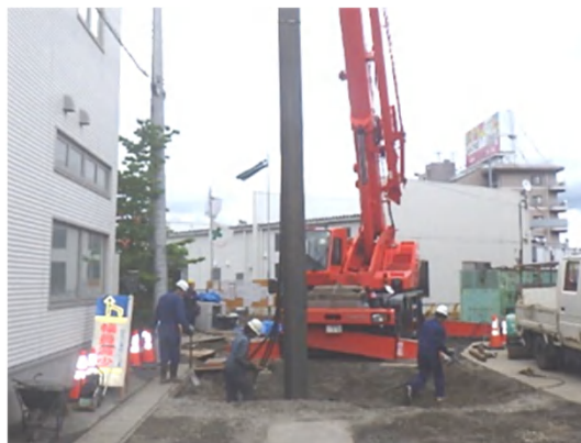
仮設土留撤去状況
