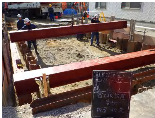
覆工板受桁等設置状況
