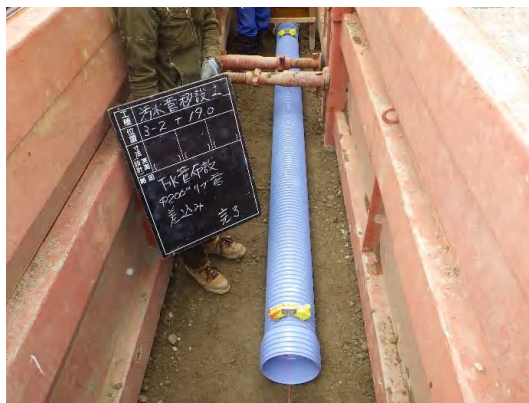
污水管移設(布設)状況
