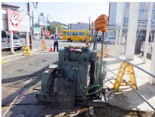
地盤改良(薬液注入)状況
