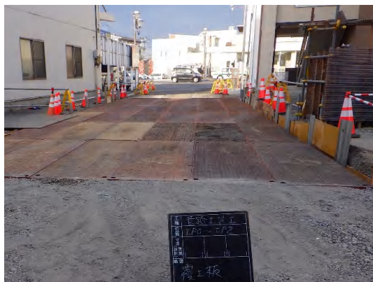
覆工板設置状況
