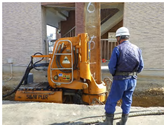
仮設土留(鋼矢板設置)状況(上流区間)
