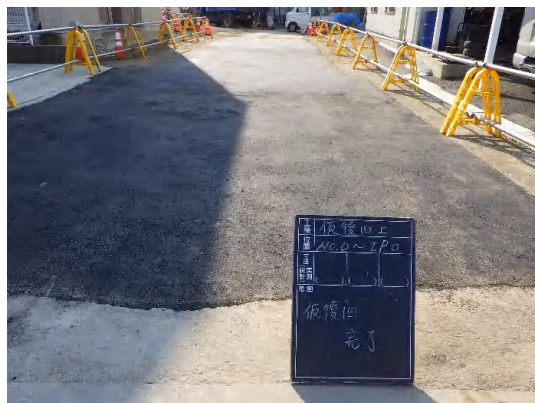
舗装仮復旧状況
