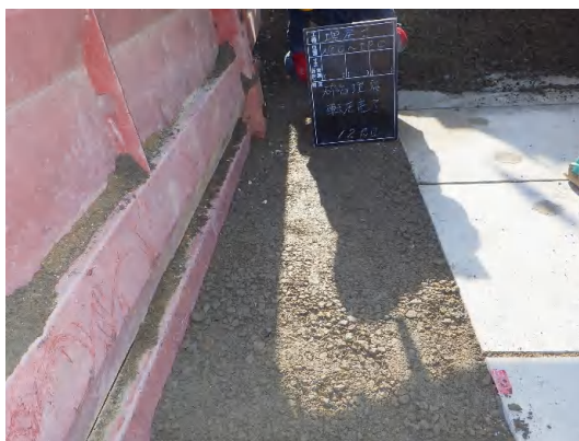
ボックスカバートの埋戻し状況
