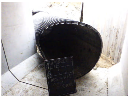
仮設排水管設置状況(下流区間)
