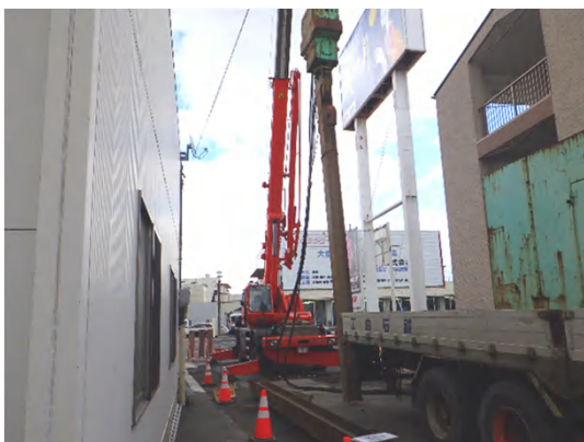
仮設土留(H鋼杭)施工状況
