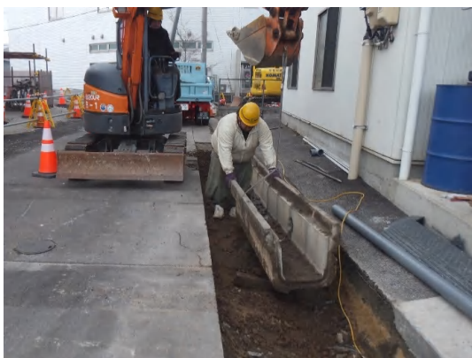
道路側溝撤去状況
