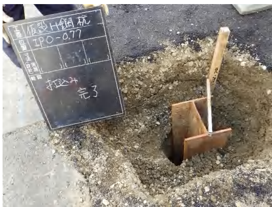
仮設土留(H鋼杭)施工状況
