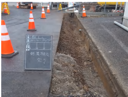
道路側溝撤去状況
