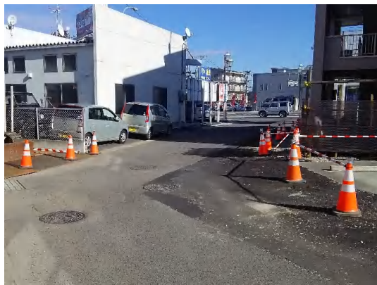
現場状況(上流側から下流側(国道49号)へ)
