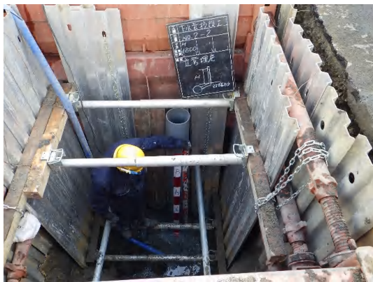
污水管移設状況
