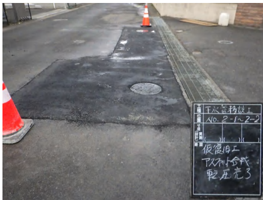
污水管移設(舗装仮復旧)状況
