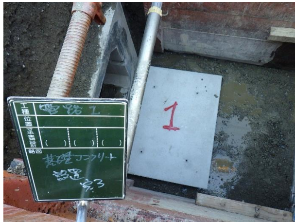
基礎(既製コンクリート板設置)工状況
