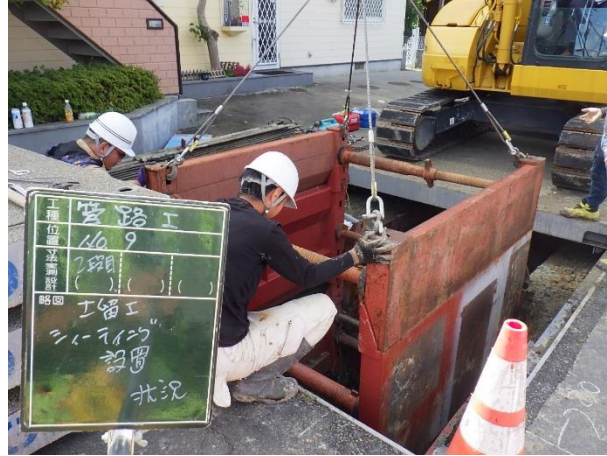
建込簡易土留設置状況
