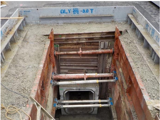
掘削・建込簡易土留設置状況
