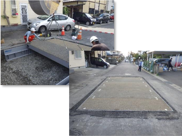
覆工板設置状況
