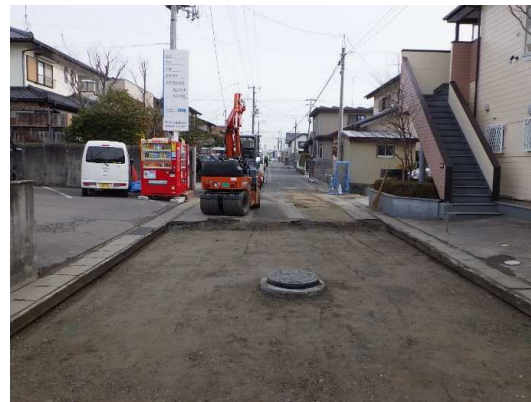
下層路盤工状況
