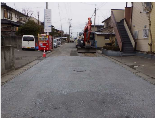
上層路盤工状況
