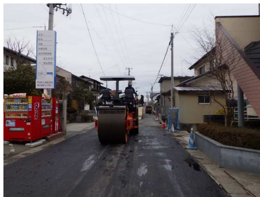
舗装仮復旧状況
