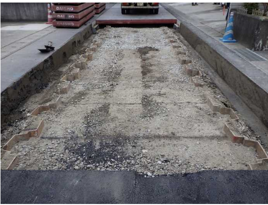
覆工板撤去状況
