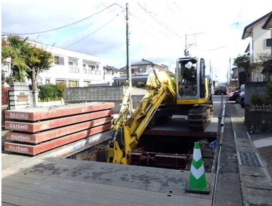
掘削・支保状況
