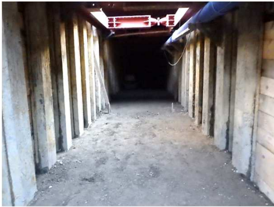
基礎工(砕石)状況
