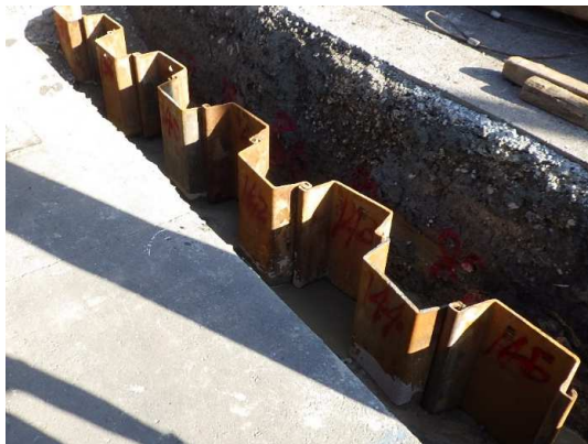
仮設土留(鋼矢板)施工状況
