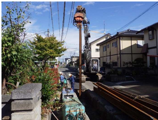
仮設土留(鋼矢板)施工状況
