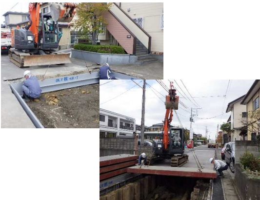
覆工板設置状況
