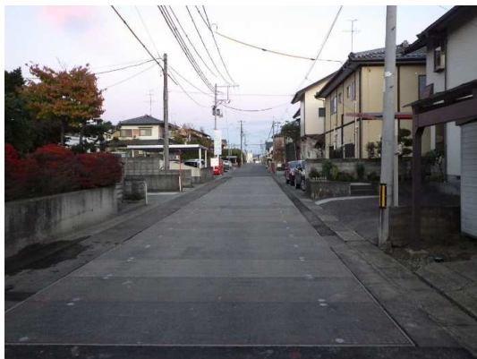
覆工板設置完了状況
