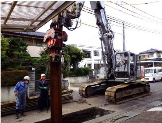
仮設土留(鋼矢板)施工状況
