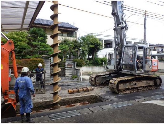
仮設土留(アースガ)施工状況
