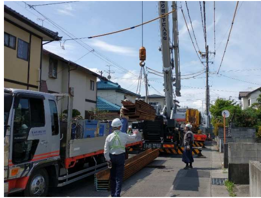
仮設土留(鋼矢板)搬入状況
