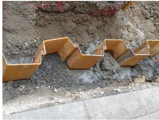
仮設土留(鋼矢板)施工状況
