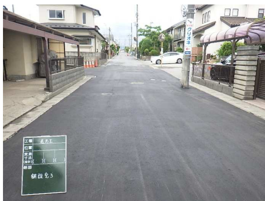
舗装仮復旧完了状況
