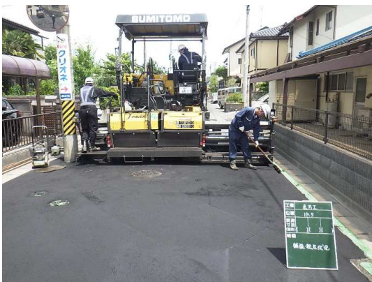
舗装仮復旧状況
