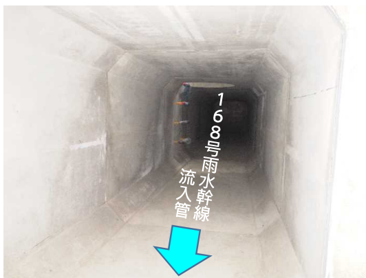
ボックスハット布設完了状況
