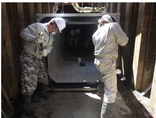
ボックスハット布設状況
