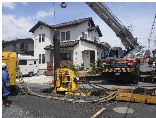
仮設土留等撤去状況
