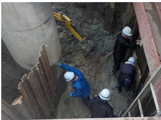
掘削・支保工状況
