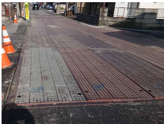
覆工板設置状況
