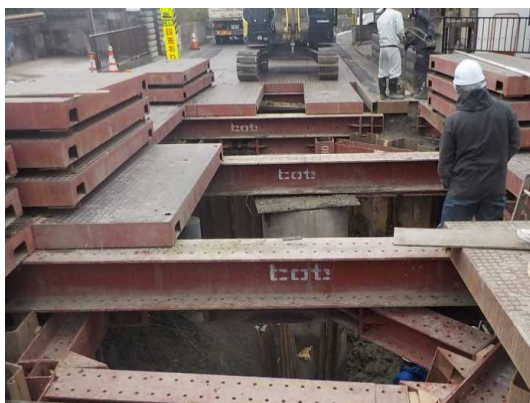
掘削・支保工状況
