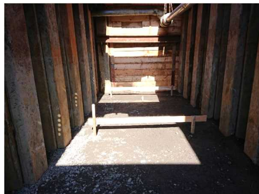
基礎工(砕石)完了状況
