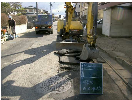
舗装取壊し状況
