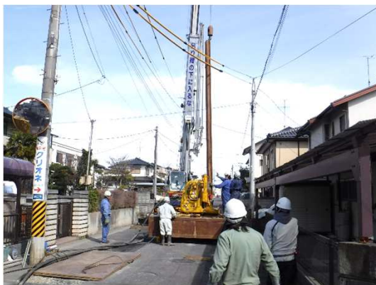
仮設土留(鋼矢板)施工状況
