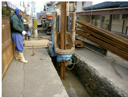
仮設土留(鋼矢板)施工状況
