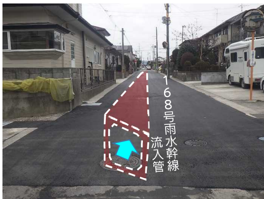
舗装仮復旧完了状況(上流側から下流側へ)
