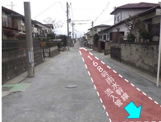
舗装仮復旧(路盤)状況(下流側から上流側へ)
