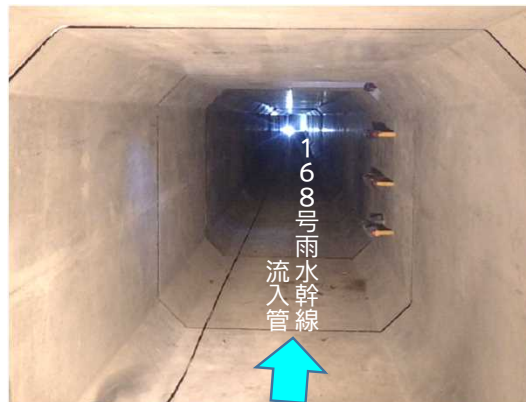
ボックスカルバート(内部)布設完了
