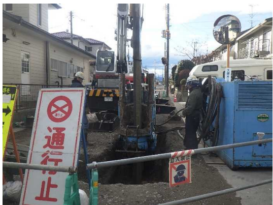
仮設土留(鋼矢板引抜)撤去状況
