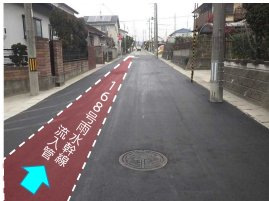
舗装仮復旧状況(上流側から下流側へ)
