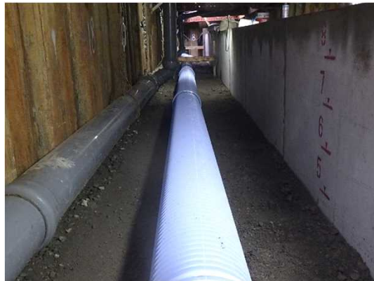
汚水管移設(復旧)状況
