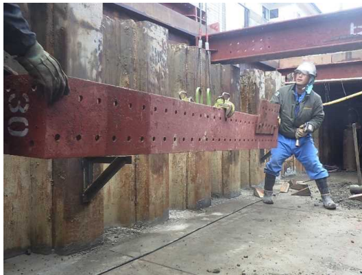
仮設土留等撤去状況
