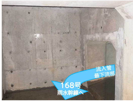
特殊人孔設置完了(内部)状況(上流側を望む)
