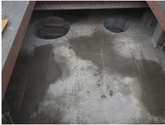
特殊人孔設置完了状況
