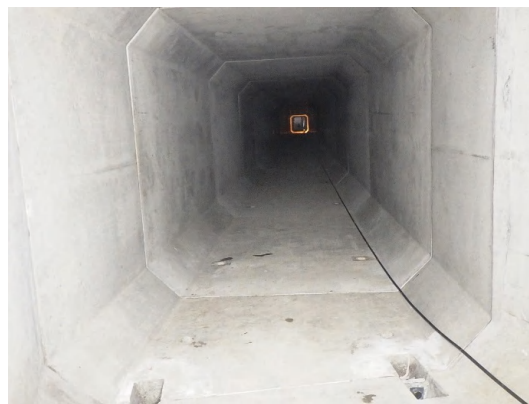
ボックスカルバート(内部)布設完了状況
