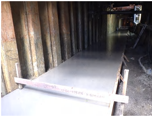
基礎工(コンクリート打設完了)状況
