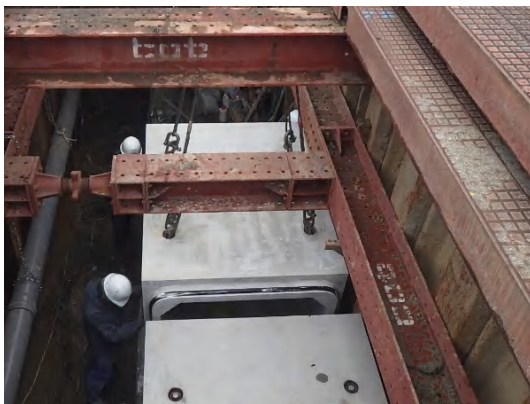
ボックスカルバート布設状況
