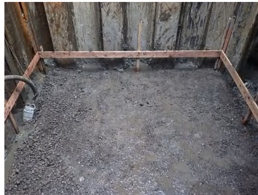
基礎工(砕石)状況
