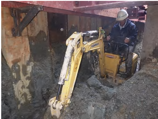
ボックスカバート布設に係る掘削・支保工状況
