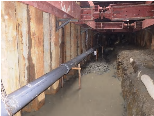
汚水管の仮移設状況
