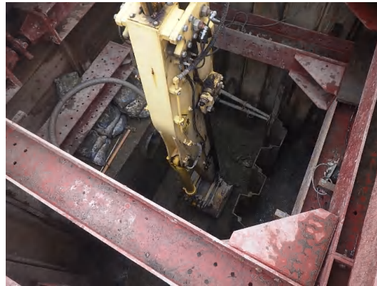
特殊人孔設置に係る掘削・支保工状況
