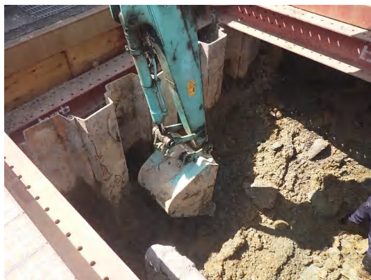
掘削(一次)状況
