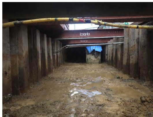
掘削(一次)状況
