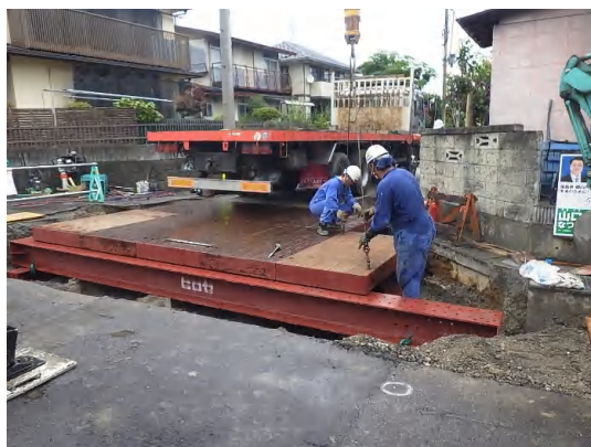
覆工板設置状況
