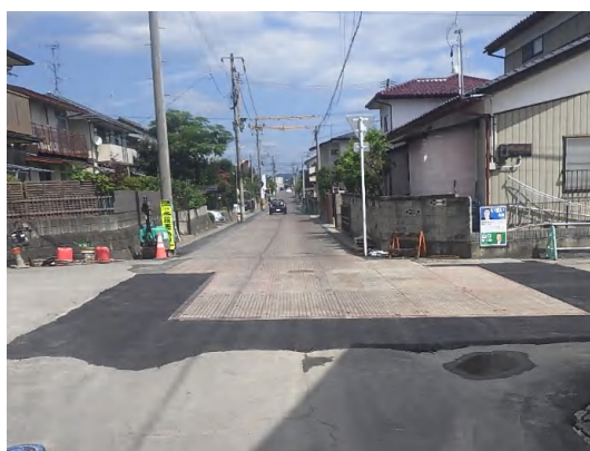
覆工板設置完了状況(上流側を望む)
