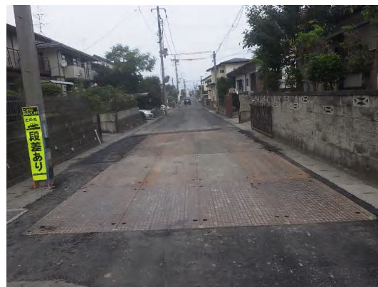
覆工板設置状況
