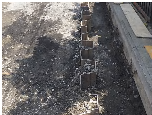
仮設土留(鋼矢板)施工状況
