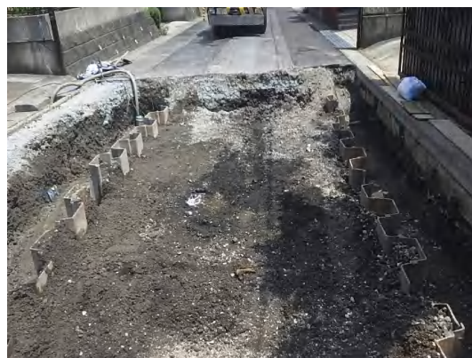
仮設土留(鋼矢板)施工完了状況
