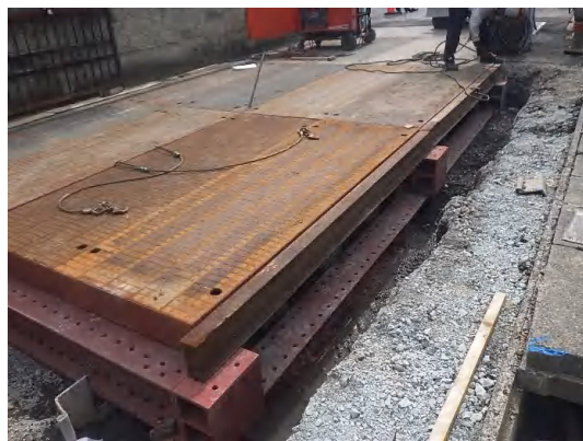
覆工板設置状況
