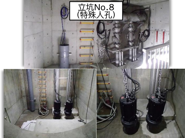
排水ポンプ及び配管設置状況
