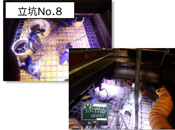
特殊人孔築造(配筋・ｺﾝｸﾘｰﾄ打設)状況
