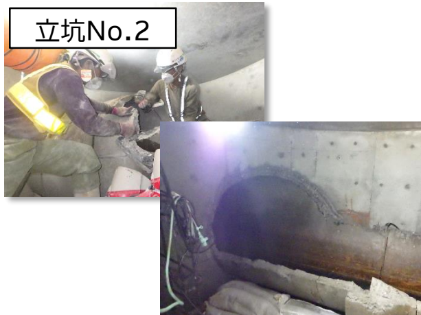
特殊人孔築造(既設管取壊し)状況
