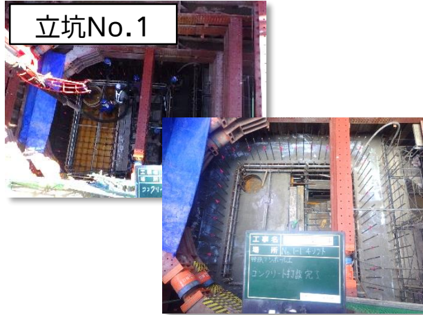
特殊人孔築造(コンクリート打設)状況
