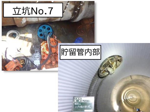
貯留管への接続(推進工事)状況
