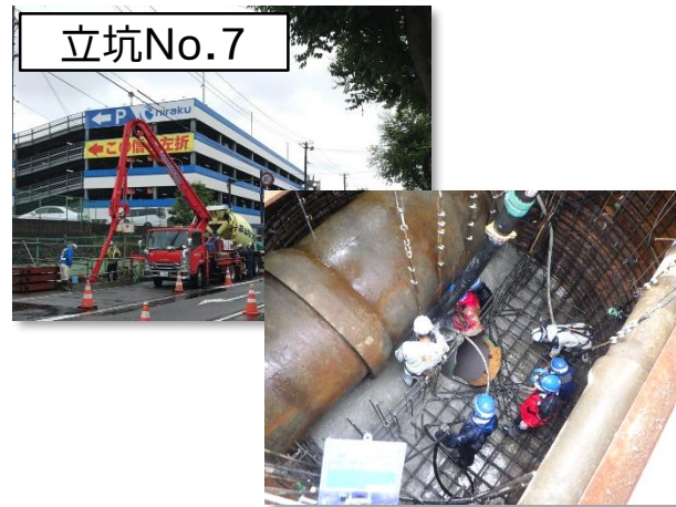
特殊人孔築造(コンクリート打設)状況
