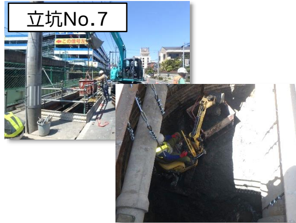
掘削・土留(ライナープレート)状況
