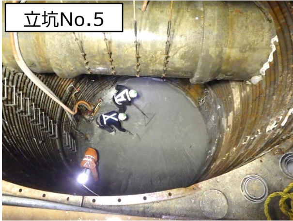
掘削・土留(ライナープレート)状況
