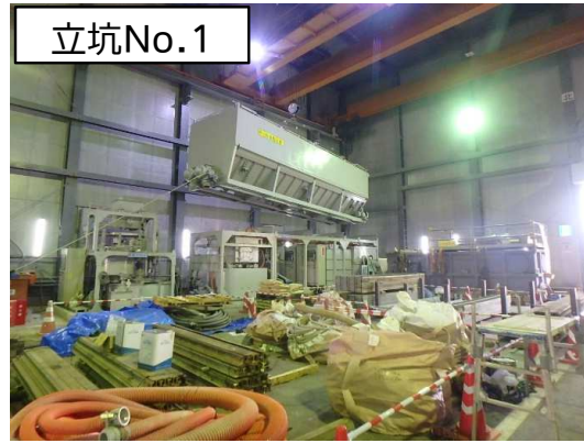
シールド工に係る各種設備撤去状況
