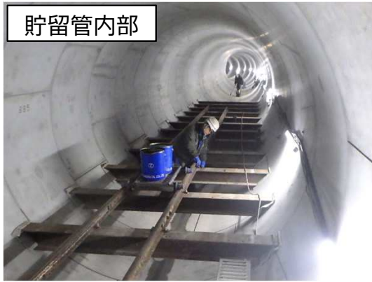
シールド工に係る軌条設備撤去状況
