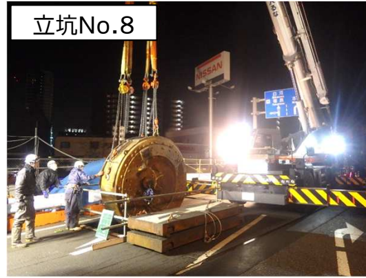
シールド掘進機の撤去状況
