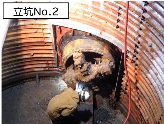
掘進機(推進工法)の到達状況
