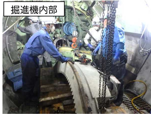
シールド掘進機の撤去状況
