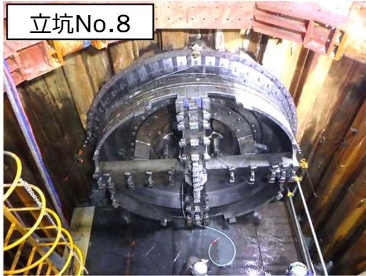
シールド掘進機の到達状況
