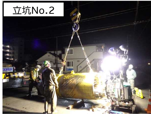
掘進機(推進工法)撤去状況
