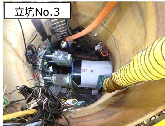
導水管築造(推進工法)状況
