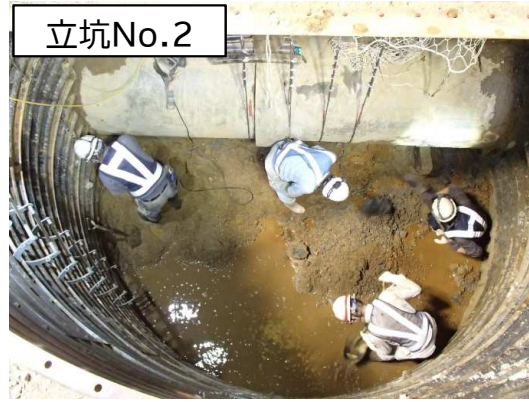
仮設土留(ライナープレート)・掘削状況
