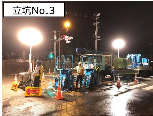
地盤改良(薬液注入)状況
