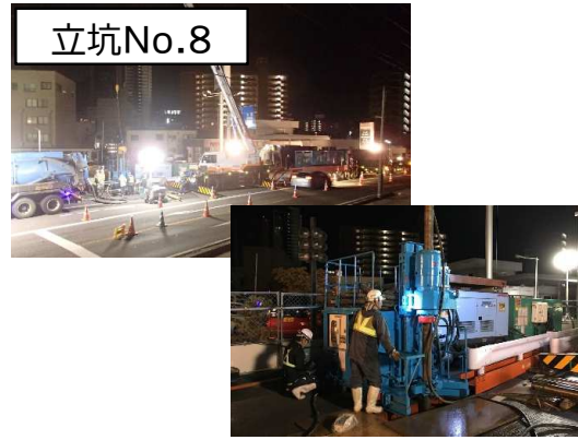
地盤改良(高圧噴射)状況
