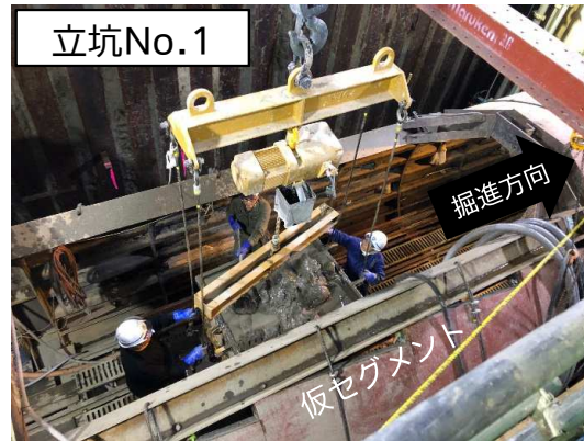
シールド掘進機による掘進状況(汚泥搬出)
