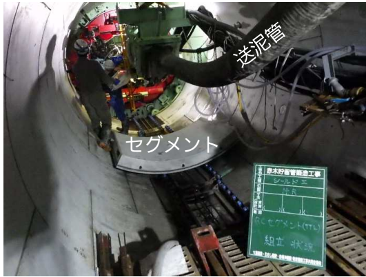
シールド掘進機による掘進状況(セグメント※設置)
