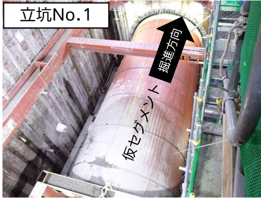
シールド掘進機※による掘進状況
