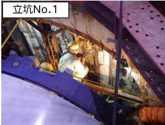
鏡切(コンクリート壁撤去)状況
