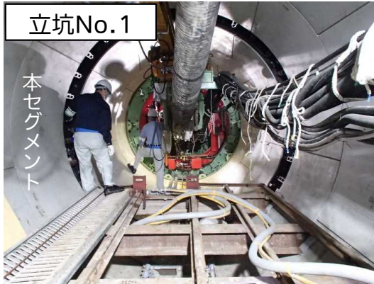
シールド掘進機※による掘進状況
