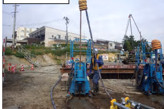
地盤改良(薬液注入)状況
