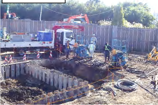
地盤改良(薬液注入)状況
