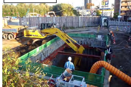
掘削・支保工状況
