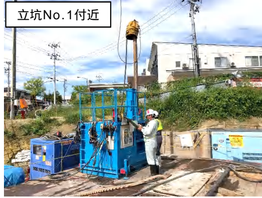
地盤改良(高圧噴射)状況
