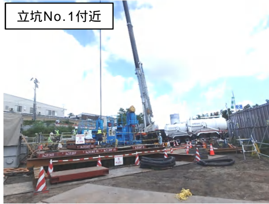
地盤改良(高圧噴射)状況
