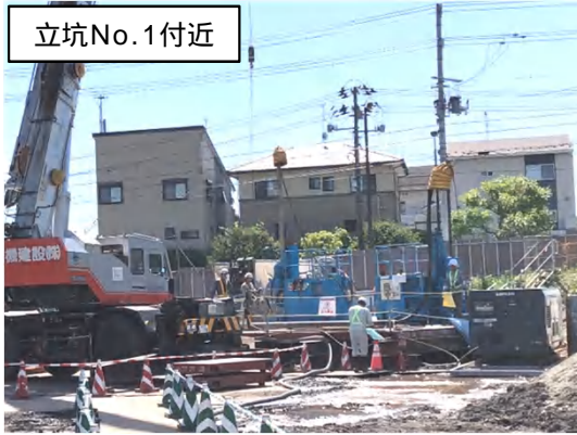
地盤改良(高圧噴射)状況
