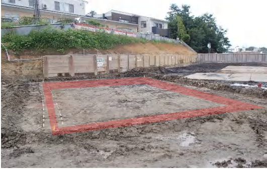
仮設土留(柱列式連続地中壁完了)状況
