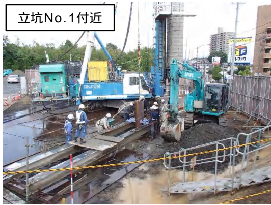
仮設土留(柱列式連続地中壁)状況
