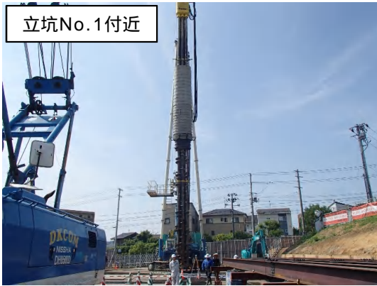
仮設土留(柱列式連続地中壁)状況
