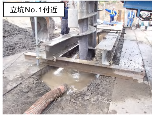
仮設土留(柱列式連続地中壁)状況
