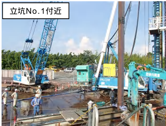
仮設土留(柱列式連続地中壁)状況
