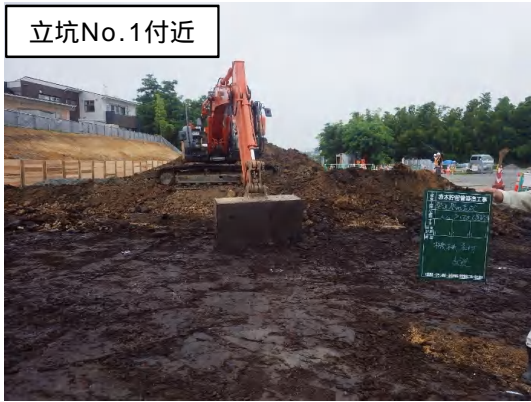
造成(掘削)状況
