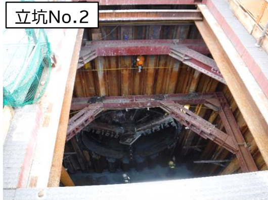
シールド掘進機の到達状況
